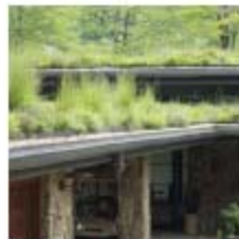
Biodiverse green roof
